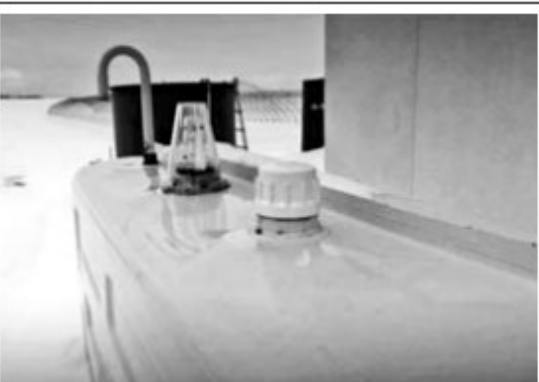
灯油タンクのキャップを兼ねたセンサー
